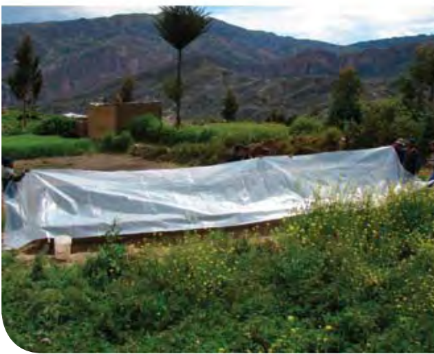
Figura 25: En el caso de altiplano hay que poner la carpa solar. Primero se ponen unos palos enterrados en los tapias, sobre ellos se echa una capa de barro fresco, encima la carpa y de nuevo barro fresco.
