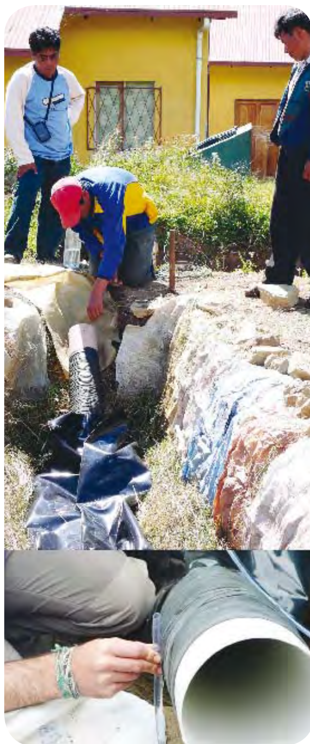
Figura 22: Para medir los niveles de salida es muy fácil se debe emplear una manguera transparente llena de agua que dará el nivel.
