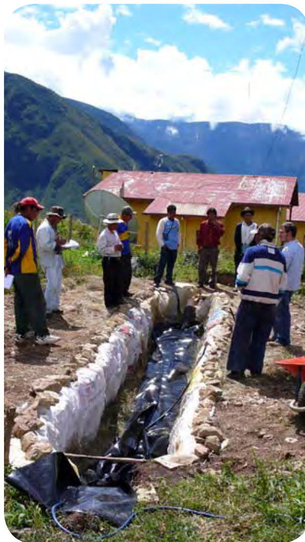
Figura 23: Biodigestor ya instalado, y empezando a ser cargado de agua y estiércol hasta que se tapan las bocas interiores de los tubos de entrada y salida.
