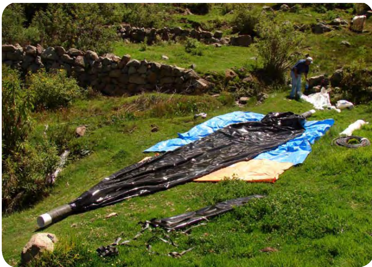
Figura 19: Biodigestor ya construido y listo para ser instalado.
