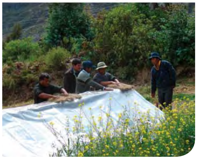
Figura 25: En el caso de altiplano hay que poner la carpa solar. Primero se ponen unos palos enterrados en los tapias, sobre ellos se echa una capa de barro fresco, encima la carpa y de nuevo barro fresco.
