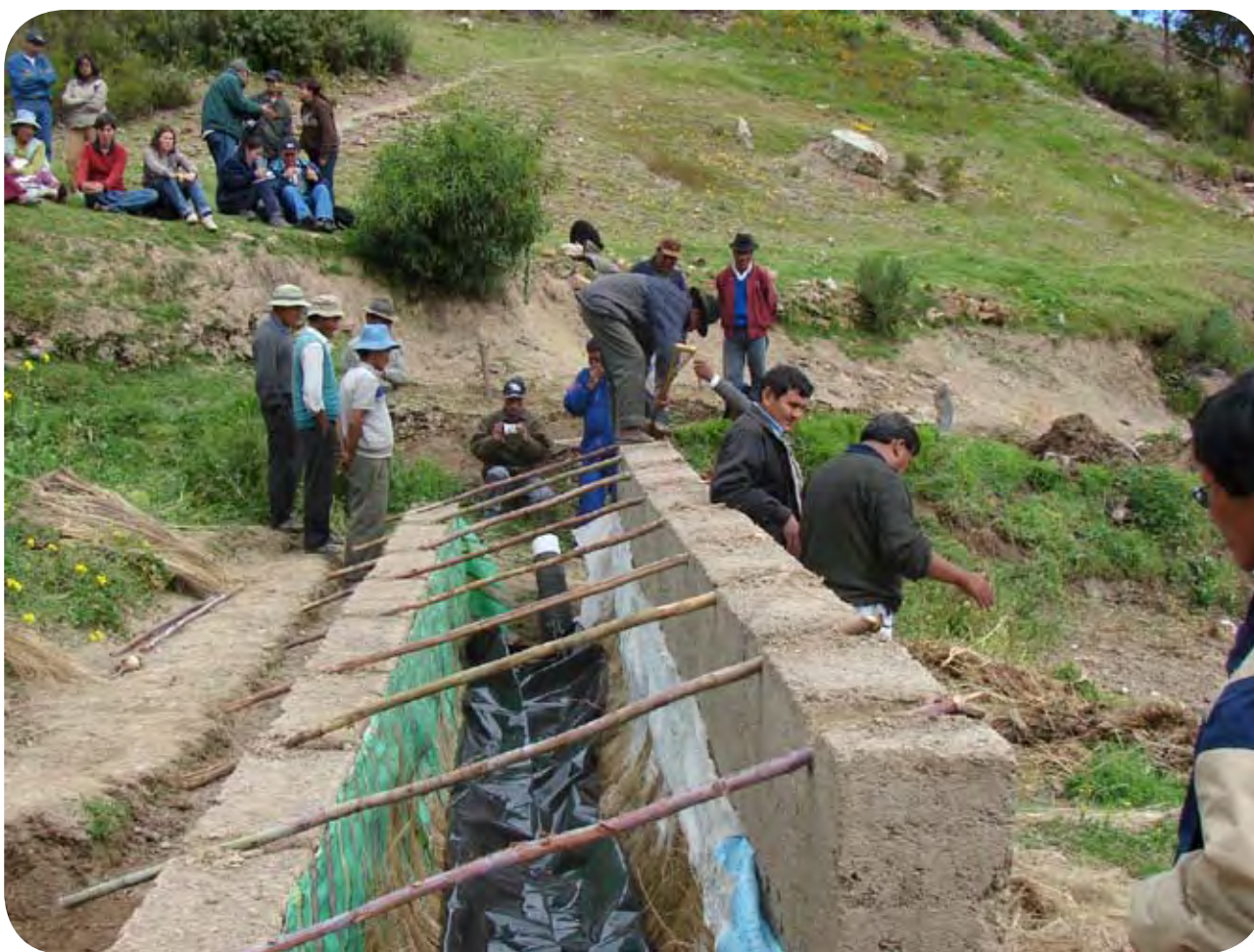
Figura 14: En el caso de biodigestores de altiplano, es necesario construir dos tapiales de adobe de unos 40 cm de grosor. Estos tapiales servirán de base para la carpa solar.
