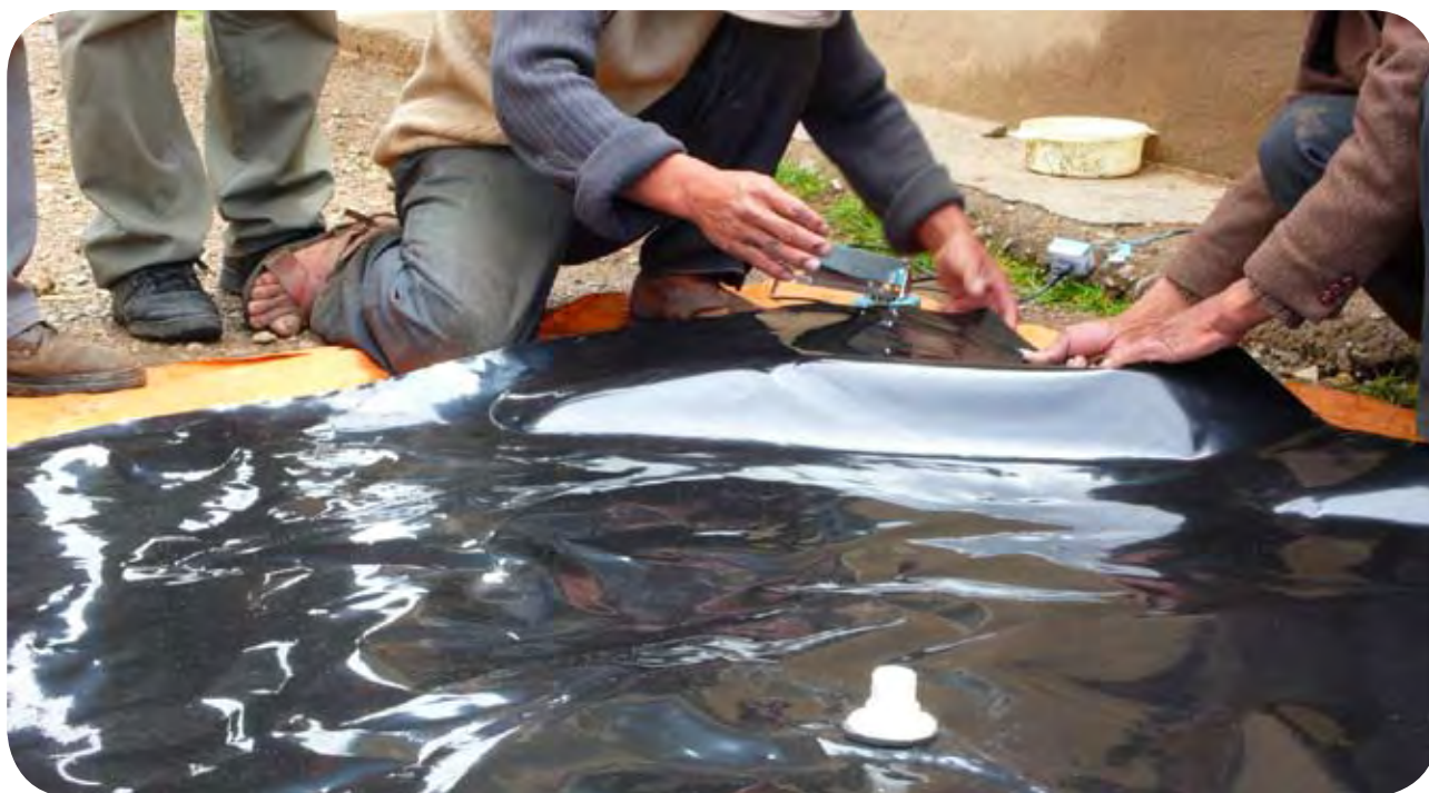
Figura 29: El reservorio se construye con 3 metros de polietileno tubular. Tras poner un pasamuros (o flange) en el centro, se sellan los extremos del plástico con una selladora manual.
