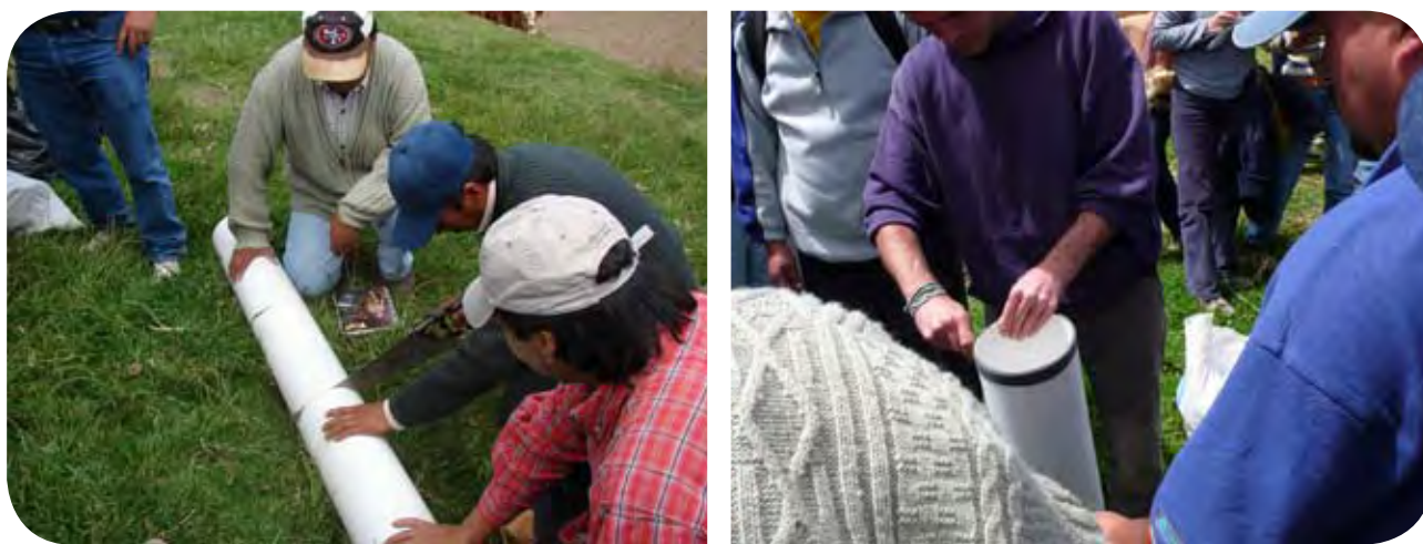
Figura 17: Las tuberías de entrada y salida son de PVC de 6” de diámetro. Normalmente se compra un tubo de 4 m, que hay que cortar en cuatro piezas de un metro cada una. Hay que proteger las bocas del tubo de entrada y el de salida que van a estar dentro del biodigestor. Amarrando liga neumática sobre el canto es suficiente.
