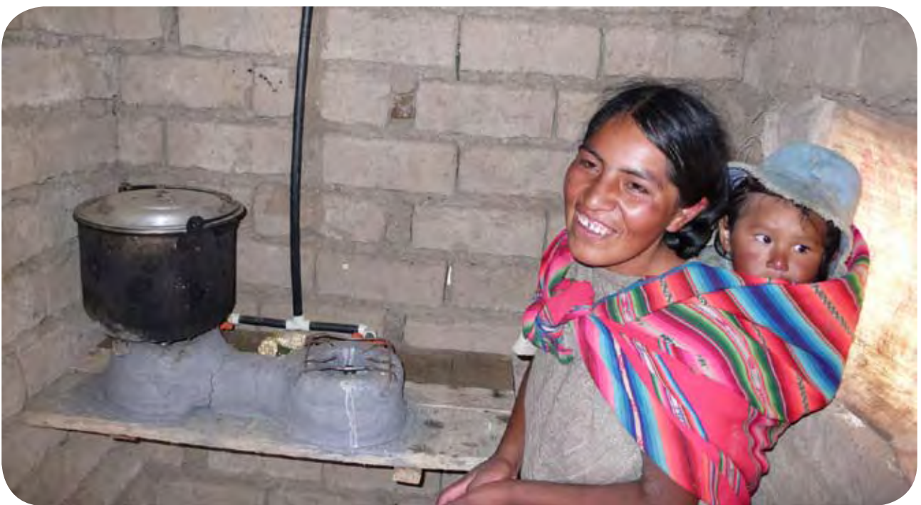
Figura 31: Las cocinas se pueden autoconstruir, acabando la conducción de biogás en tubería de ½" de hierro. De esta manera no hace falta fogón y la llama saldrá directamente de la tubería. Conviene siempre poner dos fogones. En la foto de arriba se ha seguido el esquema básico de un fogón principal y otro secundario, aunque aún falta por hacer la estructura de la cocina. En la segunda foto la cocina ya está funcionando y es de dos fogones equivalentes, dividiendo con una tee la conducción hacia ambas llaves y fogones.
